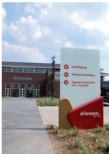
Ook zuilen en gevelbelettering vallen onder de activiteiten van Artop.
